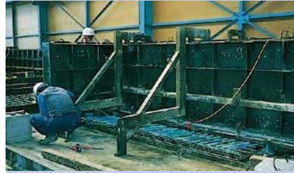
2.コンクリート打込み
