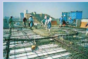
5.コンクリート打込み
