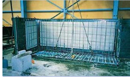
1.型枠セット・タイル張り
