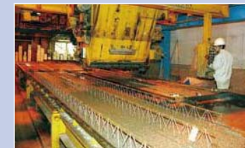
4.コンクリート打込み
