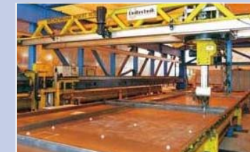
2.先付部材のセット
