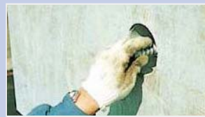
3.ネジ鉄筋の挿入
