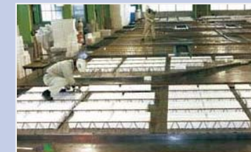
5.ボイドの取付け
