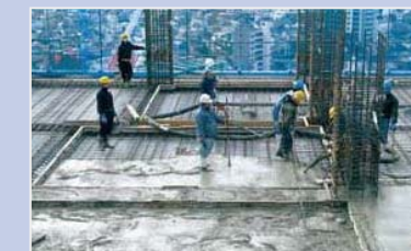
5.コンクリート打設
