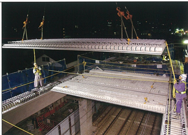
トラス鉄筋付ハーフプレキャストスラブ版架設状況
